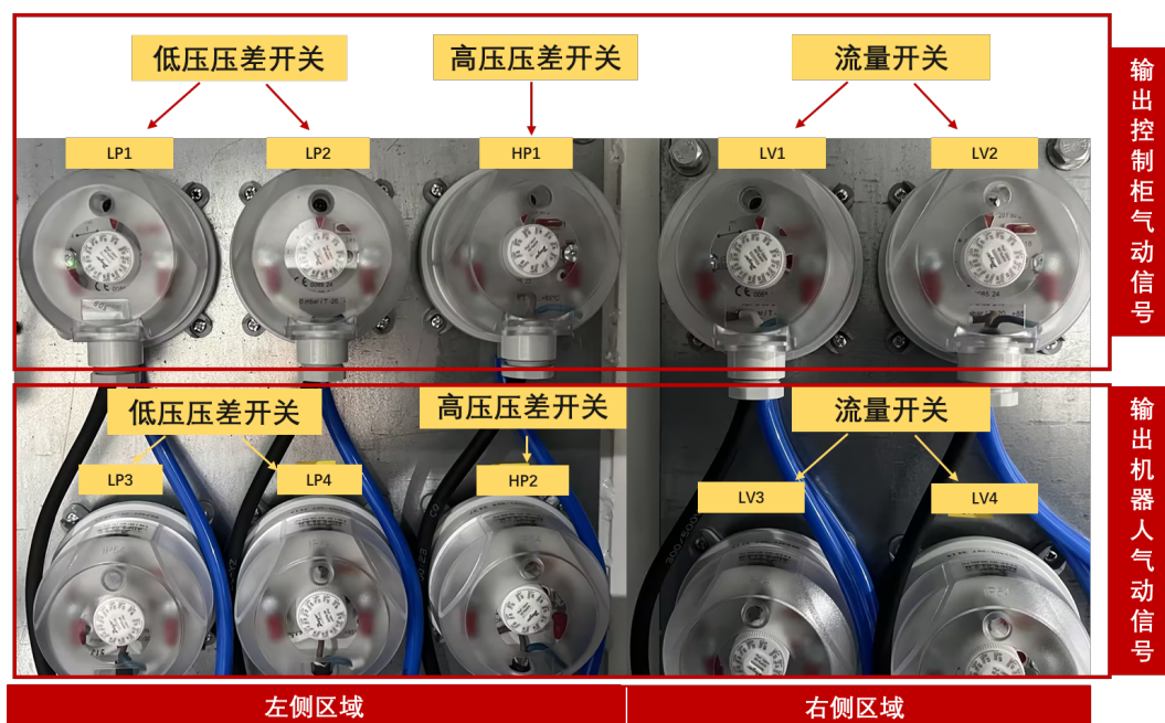
图 3-10: 防爆压差、流量开关
