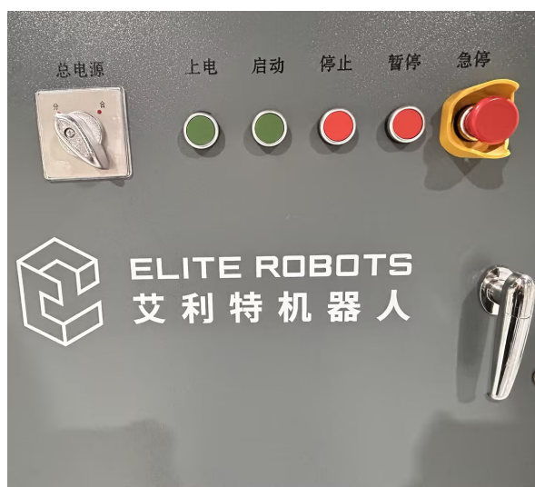
图 3-11: 正压室控制面板
