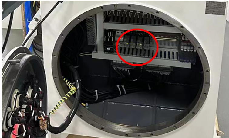
图 3-16: 隔爆腔正压控制系统内部
