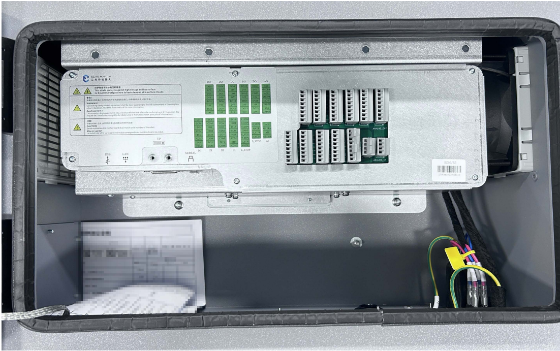
图 5-5：拆解控制柜
